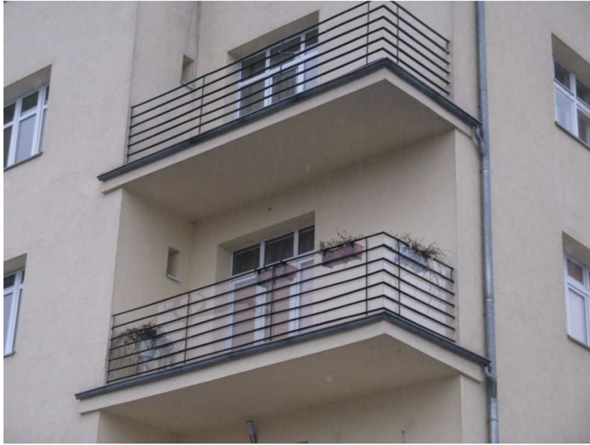
Fot. 3.14. Balkony narożne oparte na dwóch krawędziach z odwodnieniem zewnętrznym. Poznań, ul. Jarochowskiego [dokumentacja własna]
