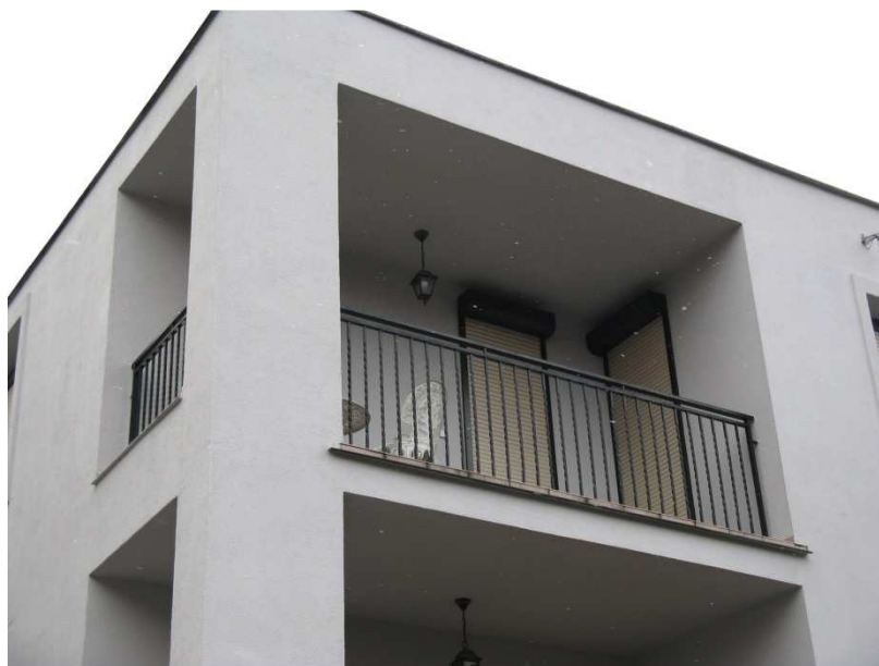
Fot. 3.16. Balkon płytowo-słupowy z systemem rolet fasadowych oraz zadaszeniem. Poznań, ul. Limanowskiego [dokumentacja własna]
