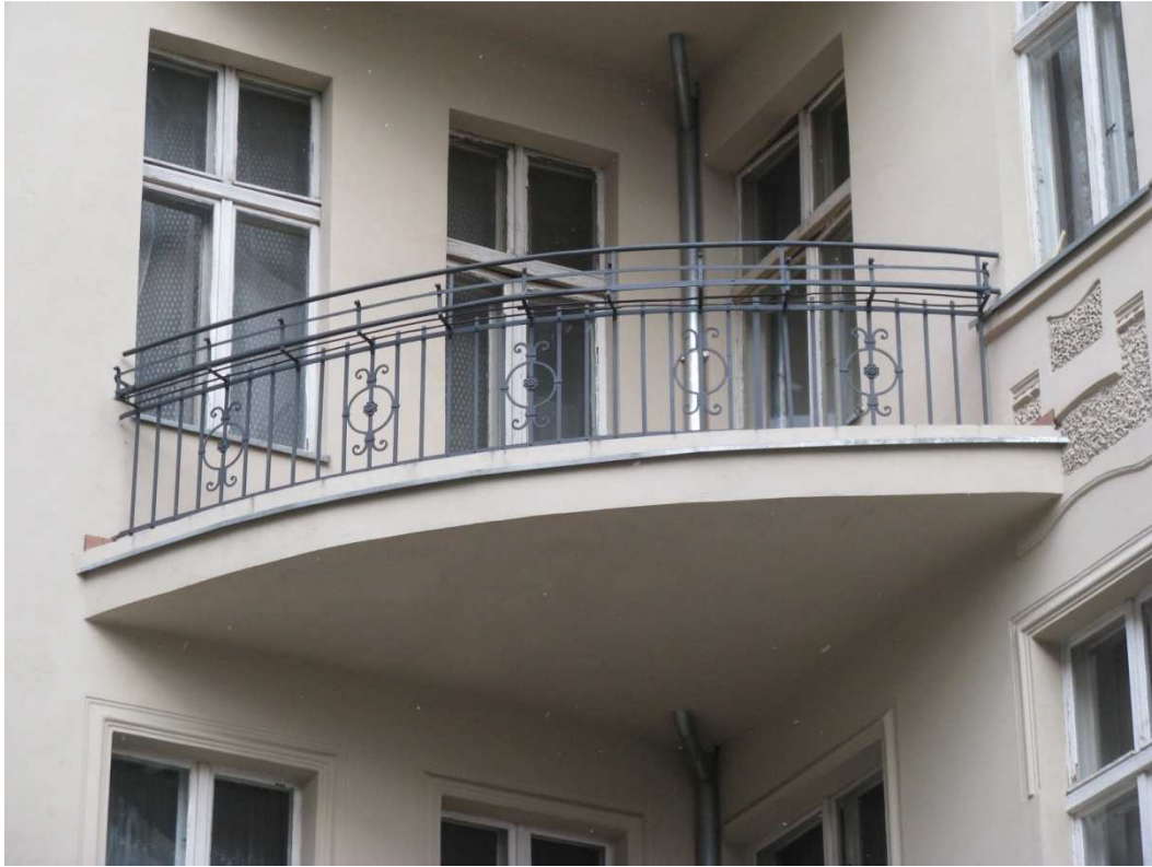
Fot. 3.5. Balkon narożny - płyta żelbetowa oparta na dwóch krawędziach. Poznań, ul. Grotgera [dokumentacja własna]
