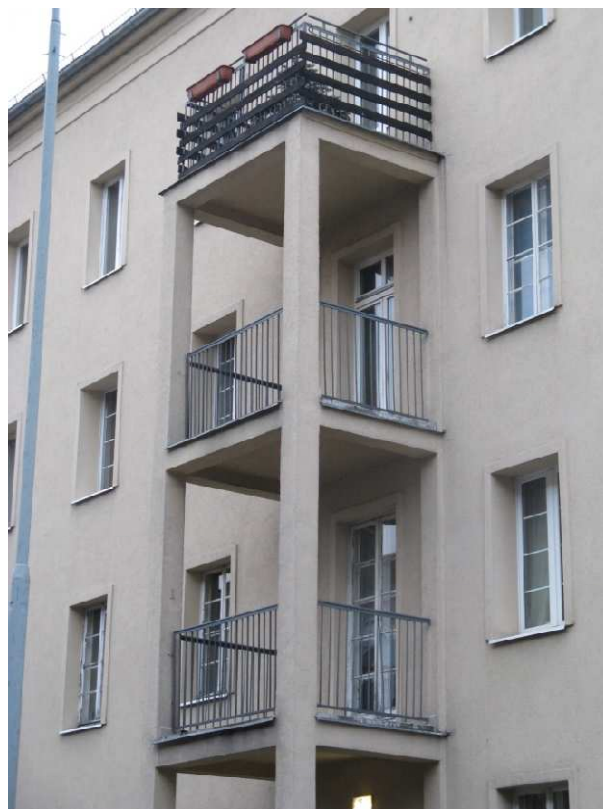
Fot. 3.10. Balkon płytowo-słupowy ze słupami żelbetowymi. Poznań, ul. Kossaka [dokumentacja własna]
