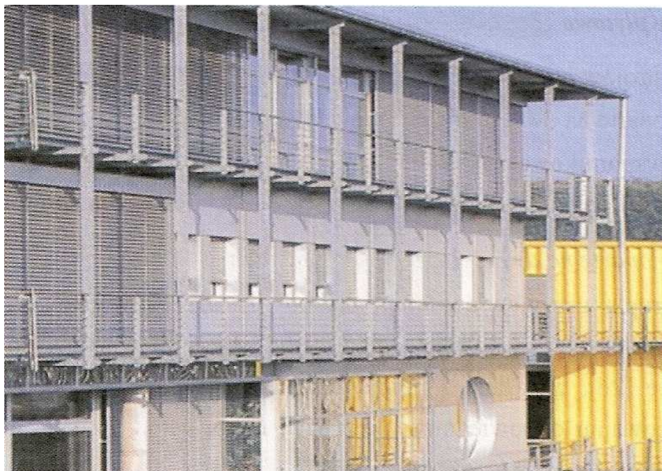
Fot. 3.3. Ustrój wspornikowo-ciężnowy [3]
