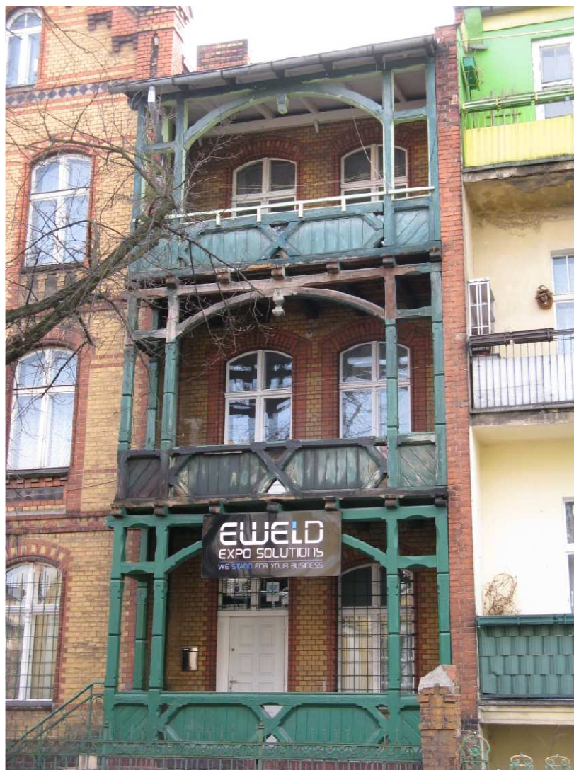
Fot. 3.17. Zabytkowy balkon o konstrukcji drewnianej zintegrowanej z konstrukcją dachową. Poznań, ul. Konopnickiej [dokumentacja własna]
