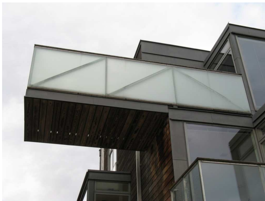
Fot. 4.11. Balkon wspornikowy o dużym wycięgu. Malmö, Szwecja [dokumentacja własna]
