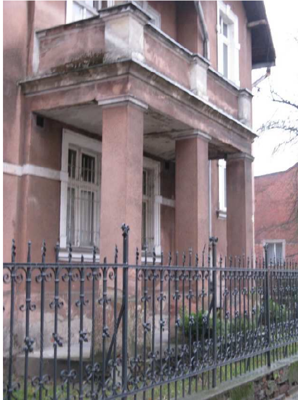
Fot. 3.11. Wejście kolumnowe. Poznań, ul. Niegolewskich [dokumentacja własna]
