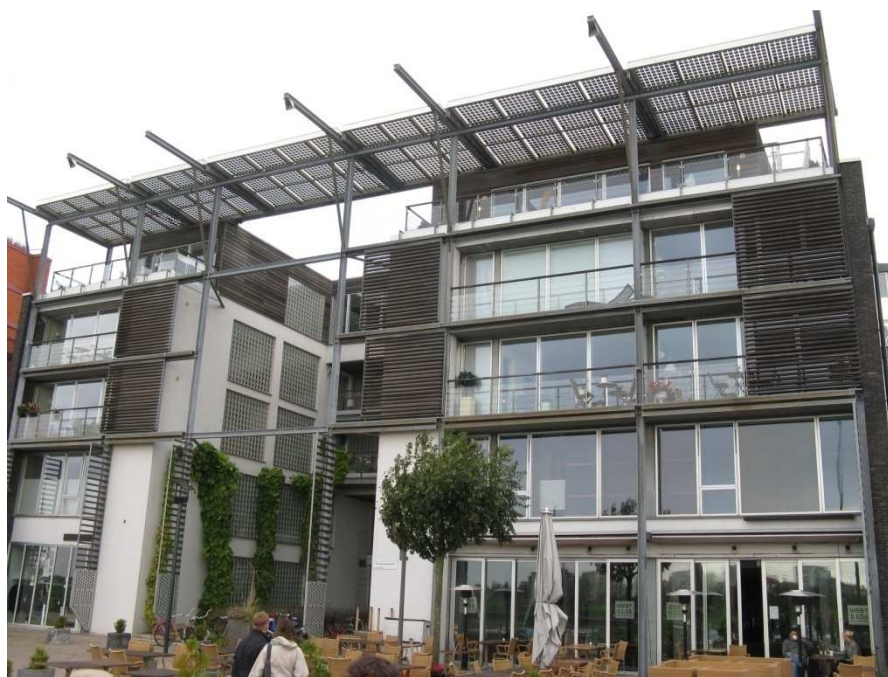
Fot. 4.12. Zadaszenie balkonu może jednocześnie pełnić rolę kolektorów słonecznych, dzięki czemu można oszczędzać energię. Malmö, Szwecja [dokumentacja własna]
