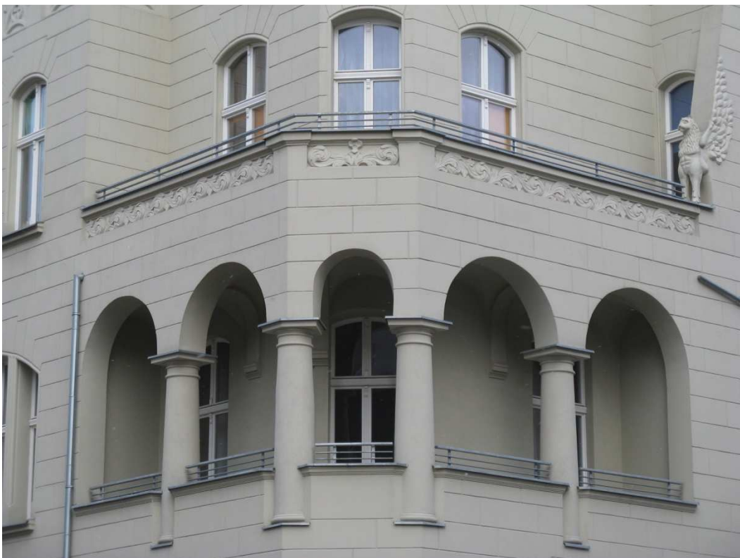
Fot. 3.19. Balkon - galeria słupowo płytowa (na górze) oraz loggia (na dole) w zabytkowej, odrestaurowanej kamienicy. Poznań, ul. Siemiradzkiego [dokumentacja własna]
