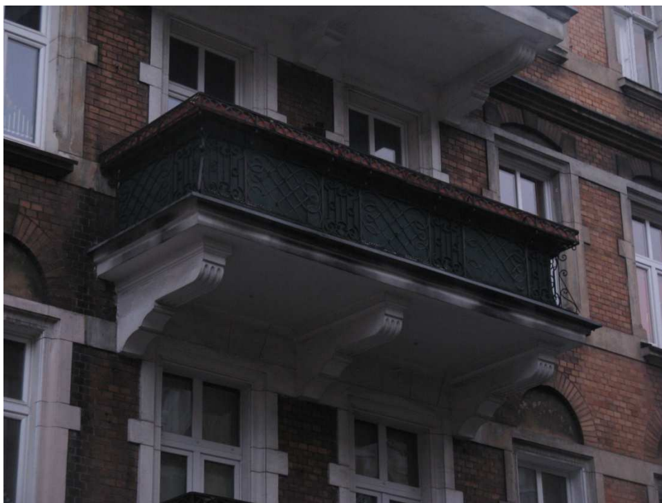
Fot. 3.1. Balkon oparty na trzech wspornikach. Poznań, ul. Małeckiego [dokumentacja własna]
