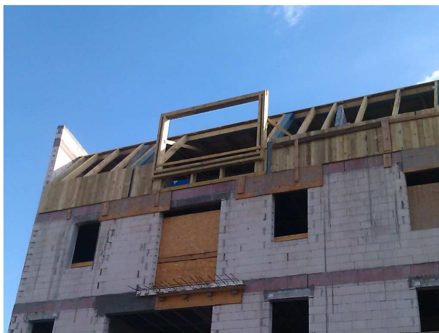
Fot. 4.6. Zdjęcie z budowy z widocznymi wystającymi prętami koszyków izolacyjnych w miejscu, w którym powstanie balkon. Poznań, ul. Górczyńska [dokumentacja własna]
