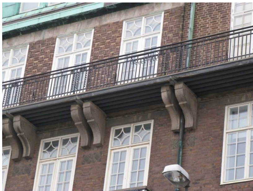
Fot. 3.8. Galeria z żelbetową płytą jednoprzęsłową - wyraźnie widoczne dylatacje między płytami. Malmö, Szwecja [dokumentacja własna]
