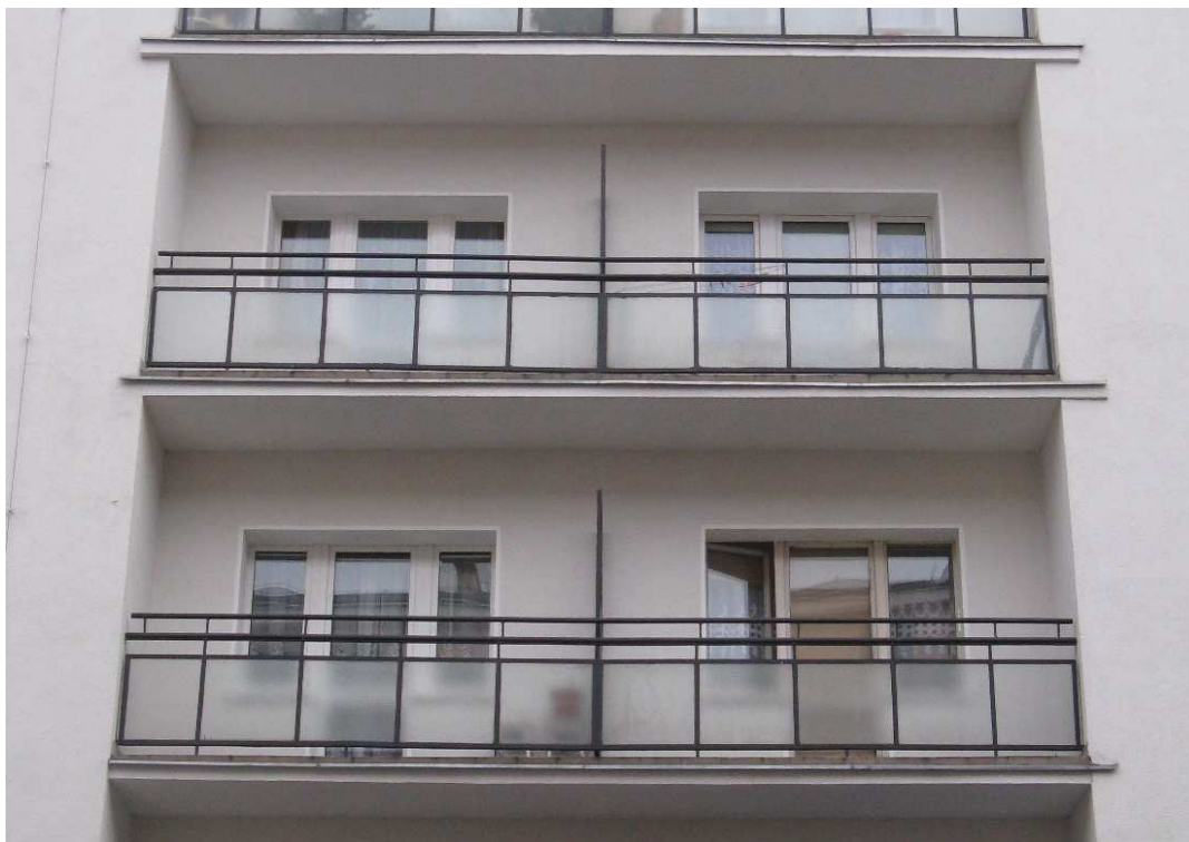
Fot. 3.6. Balkony wewnętrzne, oparte na trzech krawędziach. Poznań, ul. Kasprzaka [dokumentacja własna]
