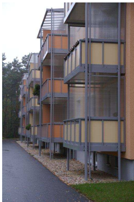
Fot. 4.8. Balkony dostawiane zbudowane po modernizacji osiedla. Rietschen, Niemcy [dokumentacja własna]
