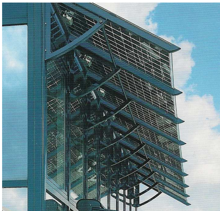
Fot. 4.13. Zadaszenie TOP SKY z ogniwami fotowoltaicznymi - ochrona przed słońcem i deszczem oraz dodatkowe źródło energii [23]
