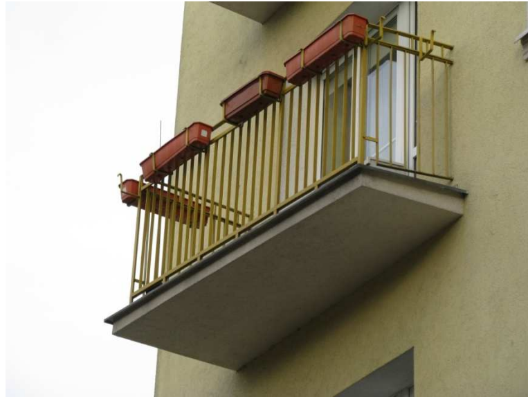
Fot. 3.7. Żelbetowa płyta wspornikowa trapezowa. Poznań, ul. Parkowa [dokumentacja własna]
